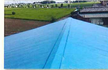
倉庫屋根遮熱(トタン)
