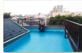
屋上遮熱(シート防水下地)
